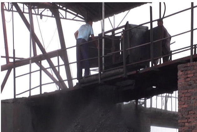
停产矿井擅自恢复施工
