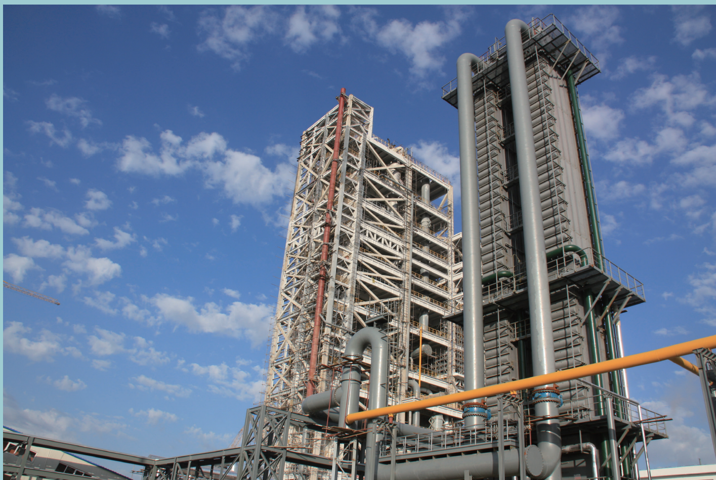
陕煤化集团煤制油项目实验装置
