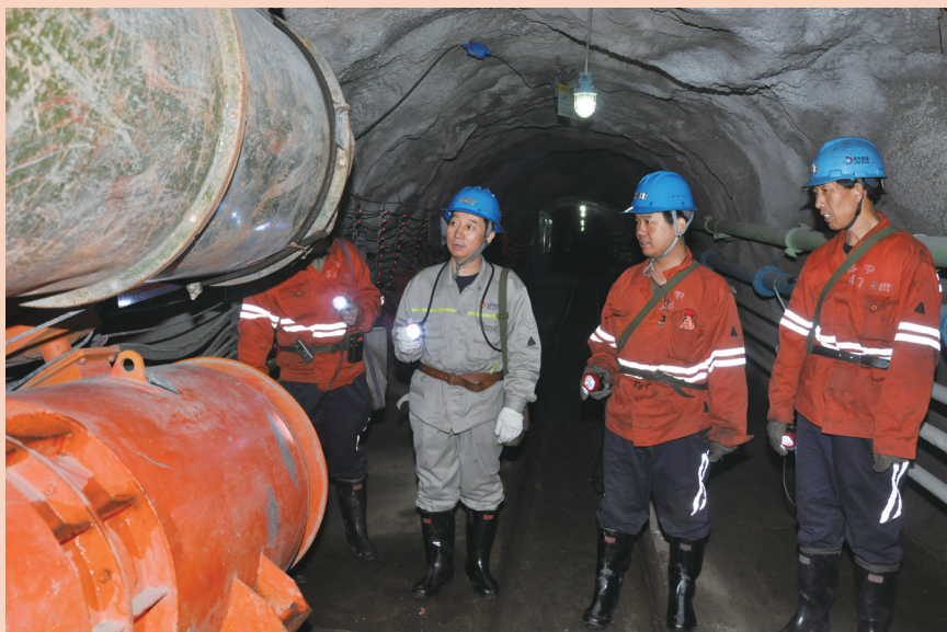
矿党委书记郝永琨在井下查找安全隐患
