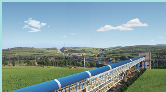
年输送能力1000万吨的金龙输煤专线
