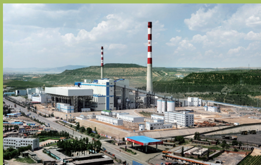
中煤平朔煤矸石电厂
