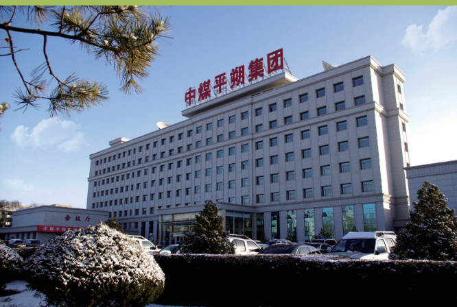
中煤平朔集团办公大楼
