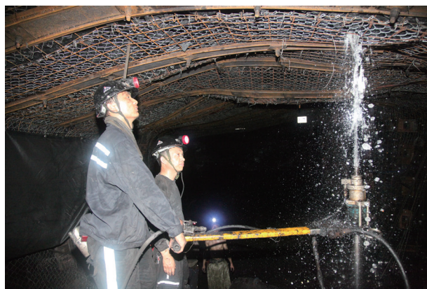
该矿员工正在进行顶板支护
