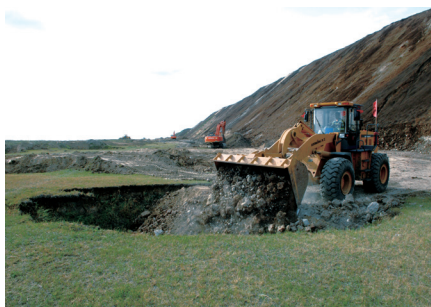
正在对历史遗留的冒顶坑进行回填治理
