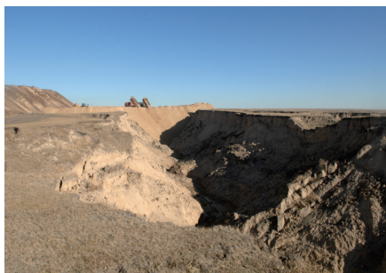
正在对历史形成的排水沟进行回填
