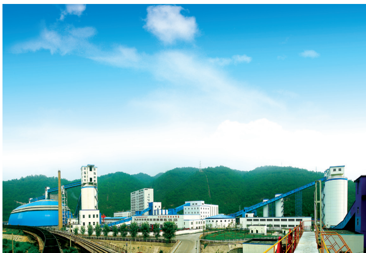
安全节能环保的现代化煤矿
