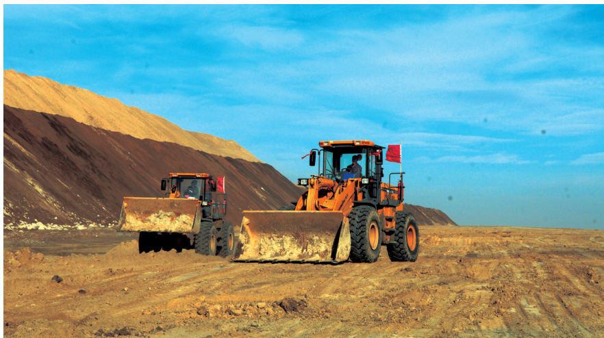
排水沟治理后
